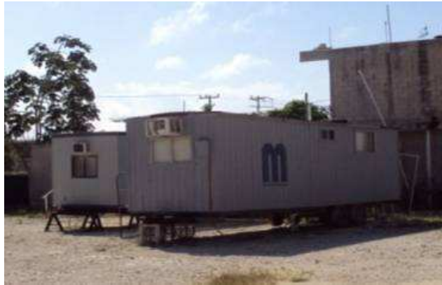
Figura 02: Oficinas de obra móvil. Por: JMMM.
