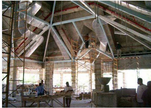
Figura 15: Construcción de Estructura con losa de concreto. Por: LAAG.
