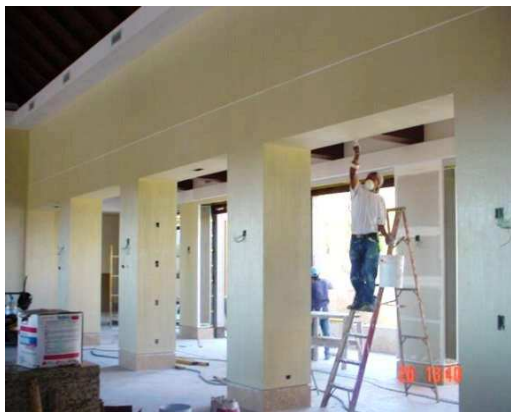
Figura 21: Obra en etapa de acabados. Por: LAAG.
