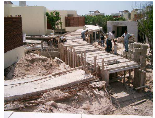
Figura 19: Colocación de tapas de trinchera. Por: LAAG.
