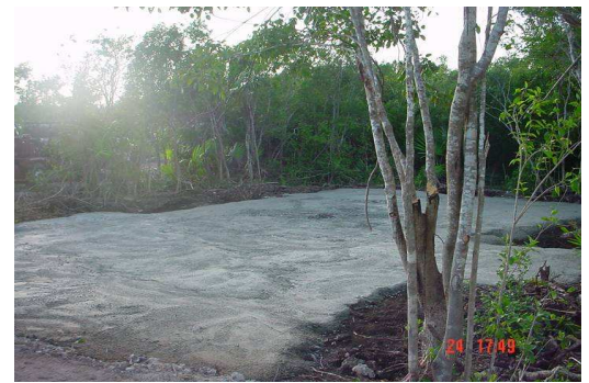
Figura 14: Remate de losa de concreto ciclópeo para desplante de cimentación. Por: LAAG.
