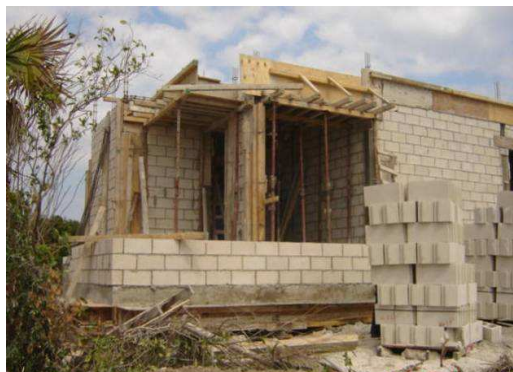
Figura 17: Construcción a base de block de concreto. Por: LAAG.
