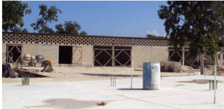
Figura 04: Bodega de obra. Por: JMMM.
