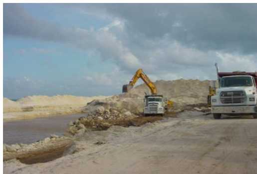
Figura 13: Etapa de excavación hasta estrato resistente. Por: LAAG
