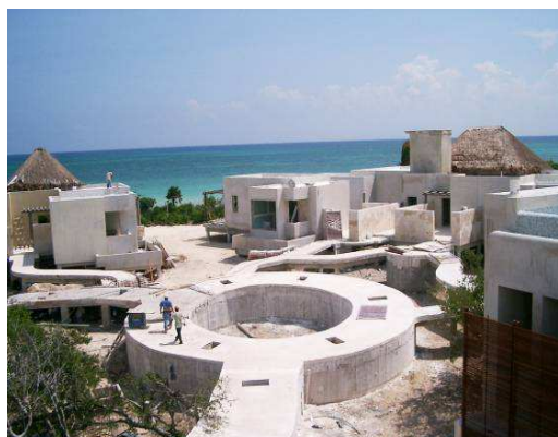
Figura 20: Trinchera terminada que servirá como rodamiento. Por: LAAG.
