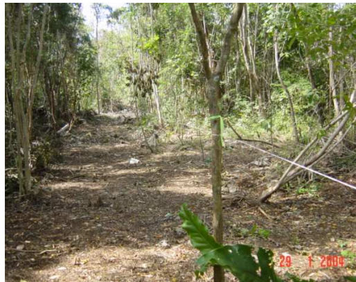
Figura 10: Trazo de eje de camino. Por: LAAG.
