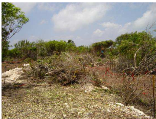
Figura 05: Trazo de área de desplante y nivelación. Por: LAAG.
