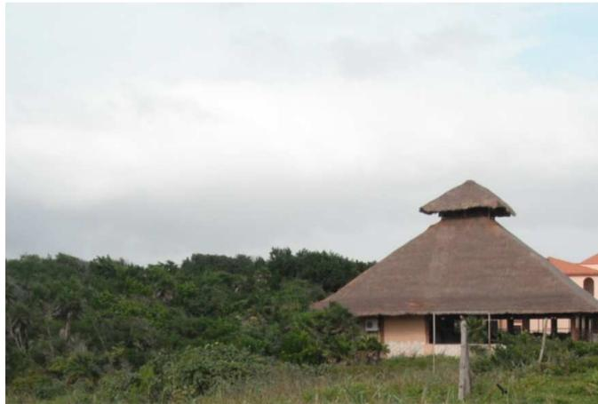
Figura 19: Cubierta autoventilada tipo palapa.
