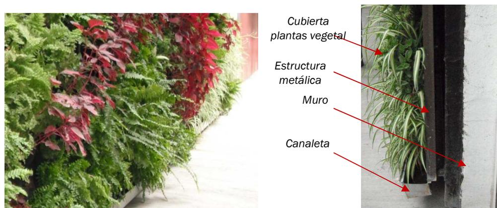
Figura 22: Estructura de Muro verde.
