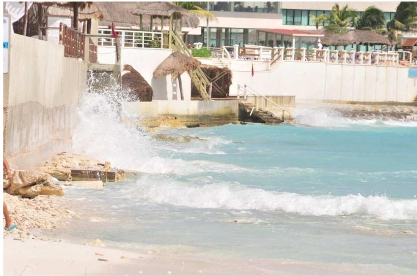
*Figura 44: Oleaje en cimentación de las construcciones.
