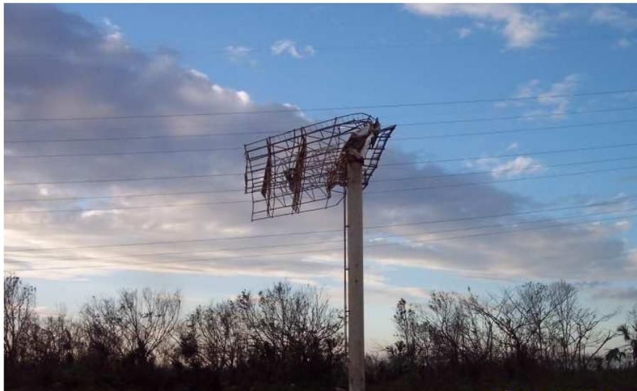
Figura 04: Estado límite de servicio. Falla por acción de empuje del viento
