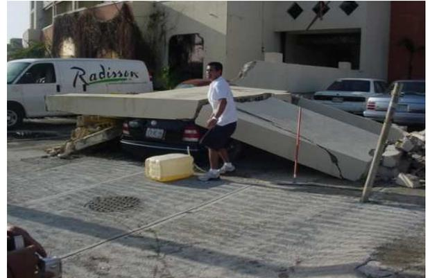
*Figura 20: Elementos no estructurales dañados por el huracán Wilma.
