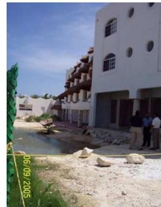
*Figura 23: Hundimiento repentino de techo de caverna no detectada por falta de estudio exploratorio.
