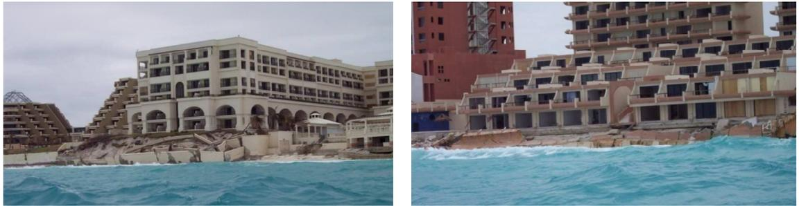
*Figura 33: Ejemplo de desastre en construcciones sin muros de retención.
