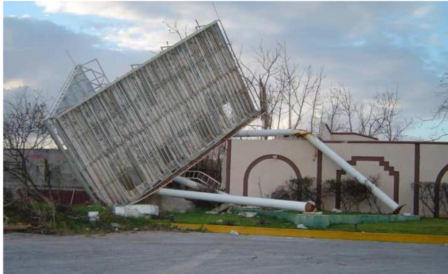
*Figura 05: Estado límite de falla. Falla por acción de empuje del viento
